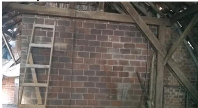
Fotografia 3 – Forro sem morcegos, colônia já abandonou o local
